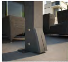
Afoering van water Drainage de l'eau de pluie
